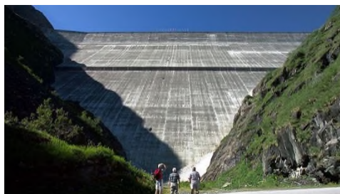
Speicherkraftwerk Grande Dixence im Wallis – mit 285 Metern Höhe ist diese Staumauer die höchste Betonstaumauer der Welt!
