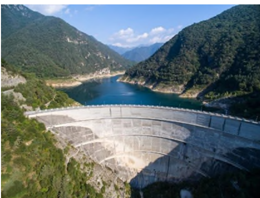
Centrale à accumulation
