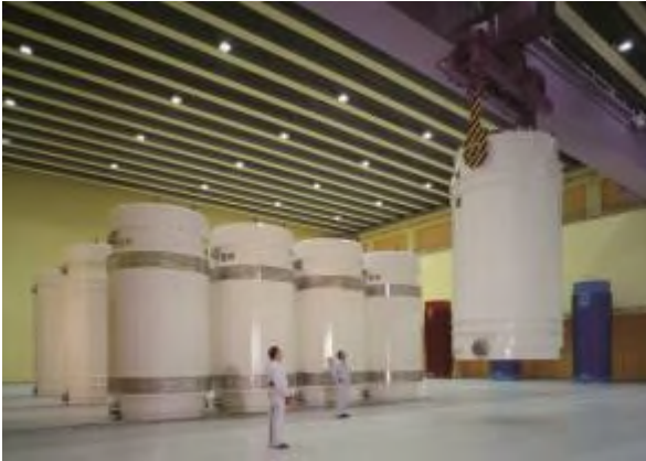
Halle de stockage des déchets de haute activité
