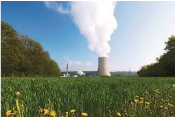
Centrale nucléaire de Gösgen (KKG)
